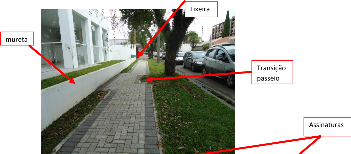
Foto 02 – Executada mureta no alinhamento predial e transição do passeio junto à árvore e lixeira dentro do lote em local de fácil acesso
