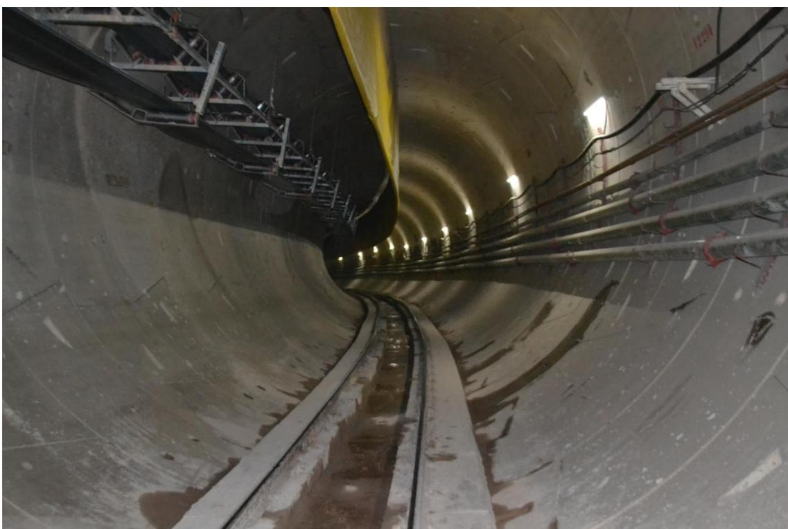
Figura 4 - Túnel resultante da escavação por Tuneladora em São Paulo/SP
