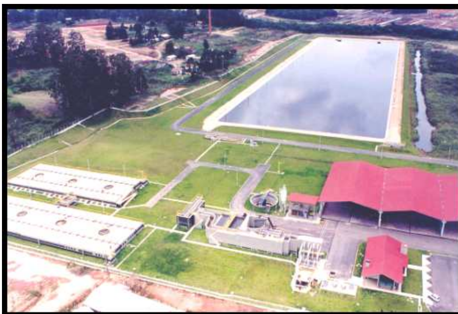
Figura 9: Vista Aérea da Estação. Fonte: SANEPAE, 2015
