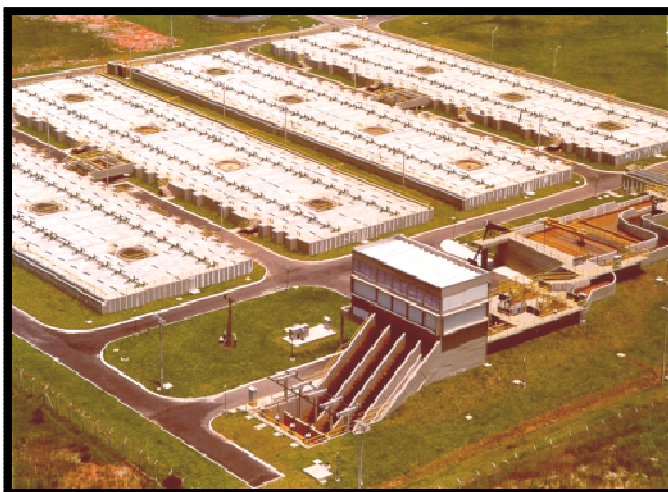
Figura 4: Vista Aérea da Estação.
