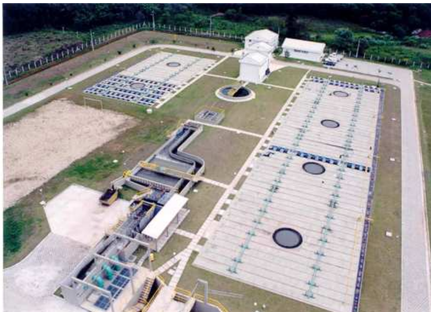
Figura 8: Vista Aérea da Estação. Fonte: SANEPAR, 2015.
