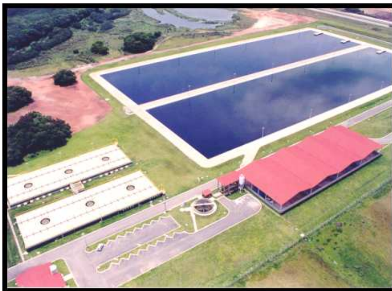
Figura 11: Vista Aérea da Estação. Fonte: SANEPAR, 2015.
