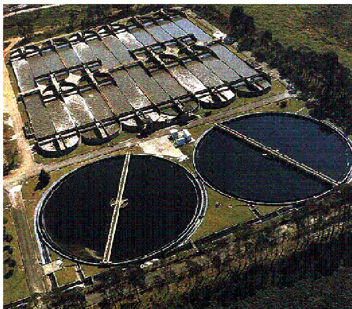
Figura 6: Vista Aérea da Estação Fonte: SANEPAR, 2015.
