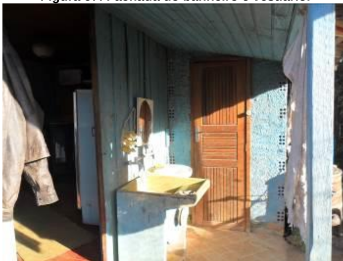
Figura 67: Fachada do banheiro e vestiário.
