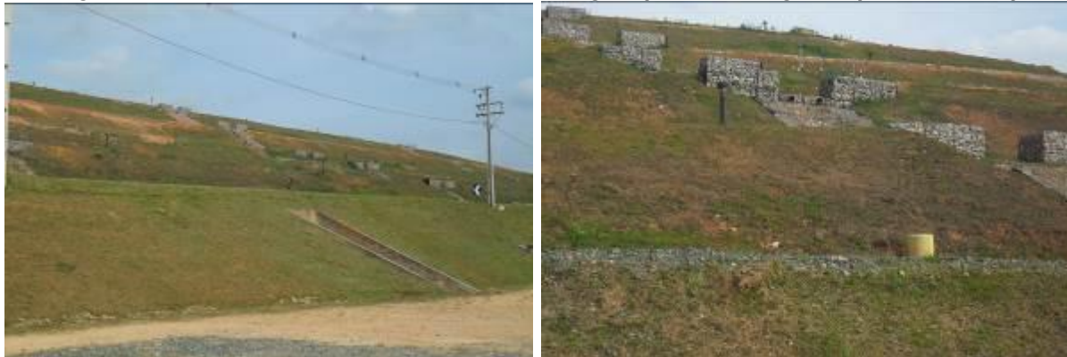
Figura 51: Célula encerrada e sistema de drenagem pluvial e de gases (outubro/2014).
