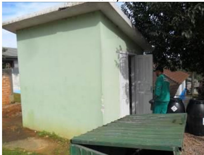
Figura 58: Local de armazenamento externo dos RSS municipais no Hospital municipal (vista Externa).
