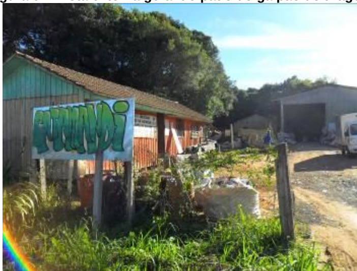
Figura 64: Vista externa geral do pátio do galpão de triagem.
