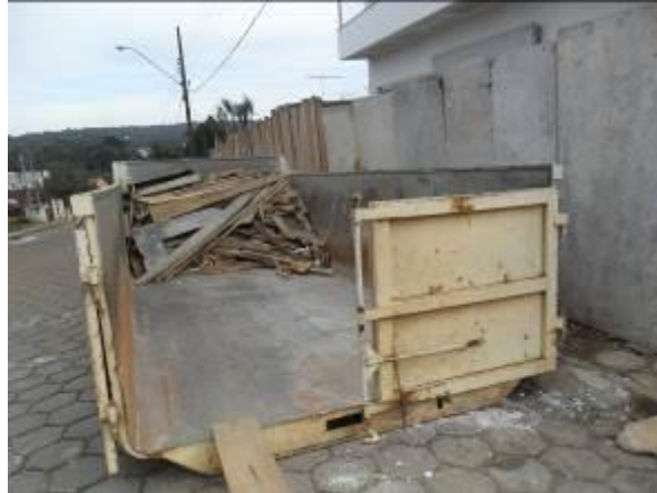
Figura 55: Resíduos da construção civil dispostos em caçambas particulares.
