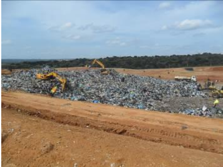
Figura 49: Frente de Trabalho da Célula em operação do Aterro Sanitário.
