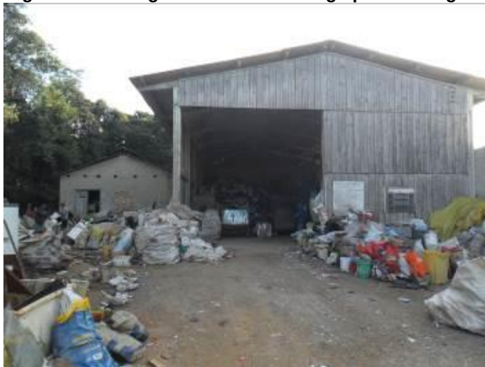
Figura 68: Vista geral da fachada do galpão de triagem.
