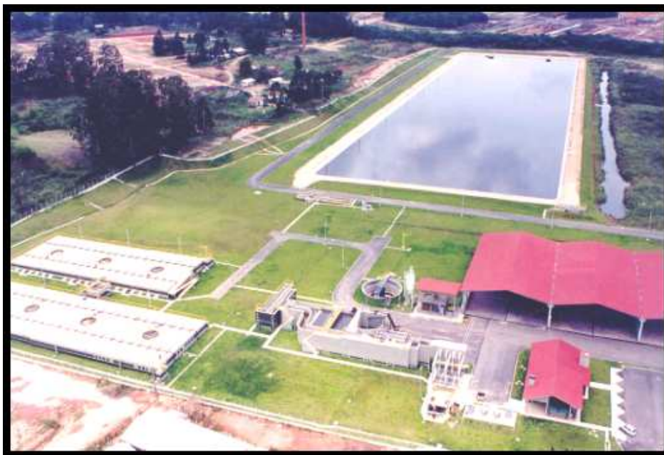
Figura 9: Vista Aérea da Estação. Fonte: SANEPAE, 2015
