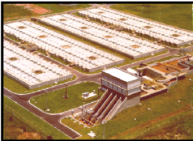
Figura 4: Vista Aérea da Estação.
