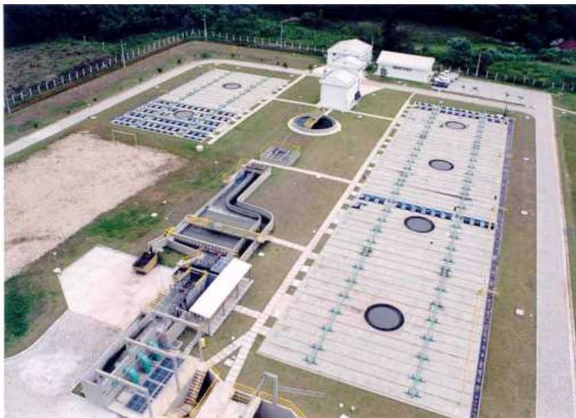
Figura 8: Vista Aérea da Estação. Fonte: SANEPAR, 2015.
