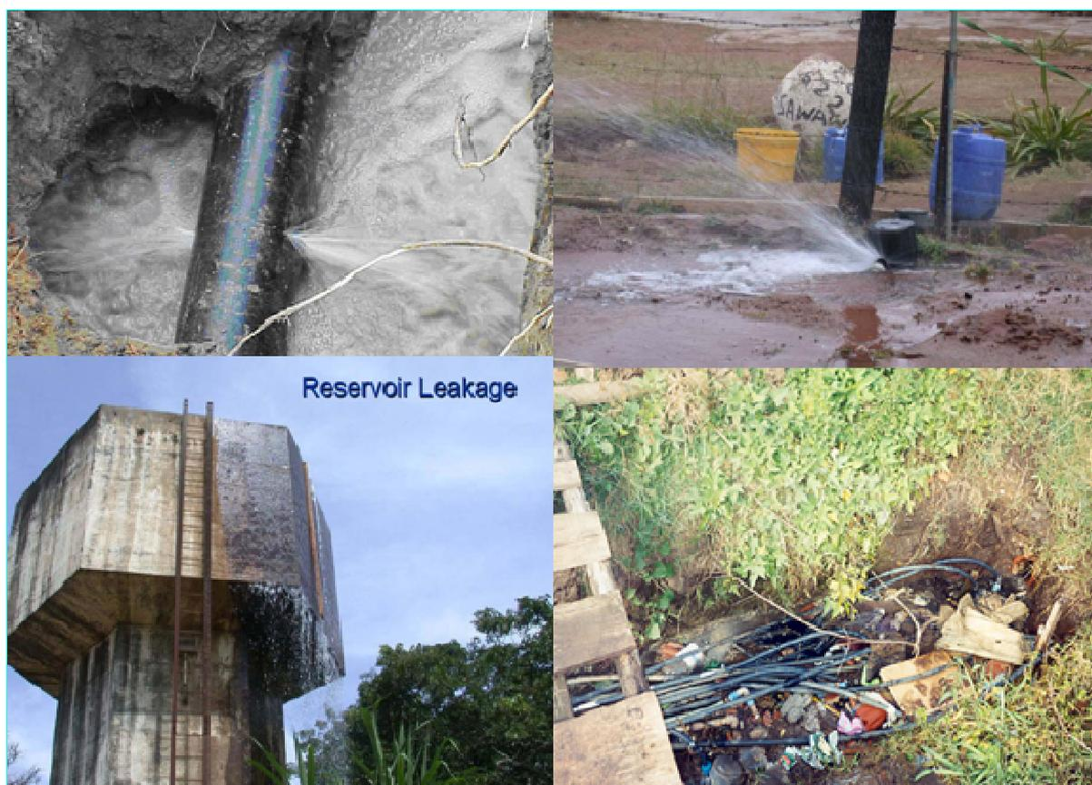
**Figura 18:** Exemplos de Rompimento de rede de abastecimento de água e em reservatório
