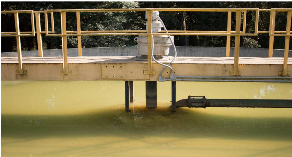
**Figura 8:** Adensador de lodo
