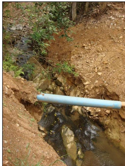
**Figura 54 - Aterro mal compactado.**
