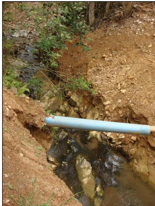
**Figura 54 - Aterro mal compactado.**
