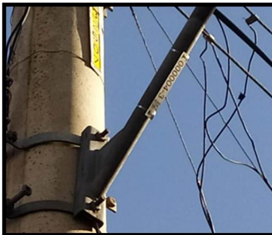
2 – no sentido transversal ao braço, a partir da utilização de uma abraçadeira “topo D” rebitada no centro da plaqueta.
