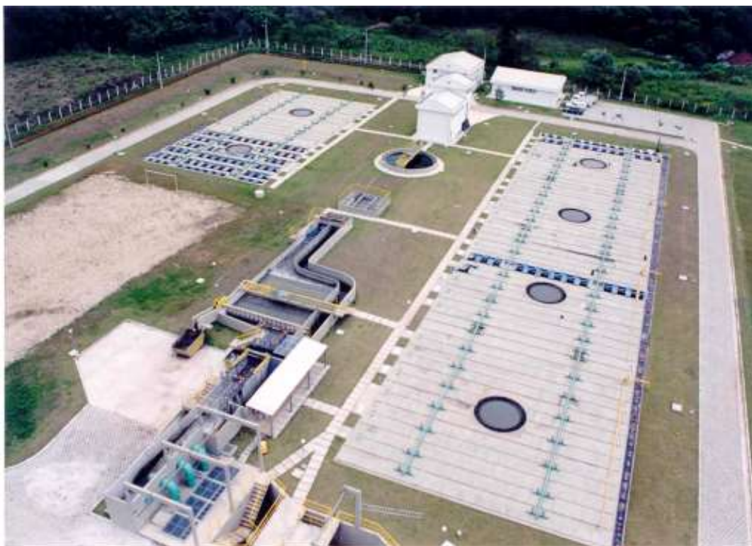
Figura 10: Vista Aérea da ETE Santa Quitéria, Fonte: SANEPAR, 2015.
