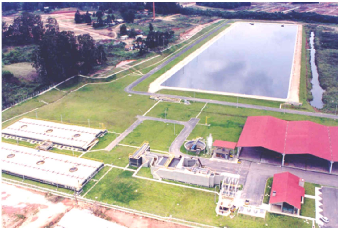
Figura 11: Vista Aérea da ETE CIC-Xisto. Fonte: SANEPAR, 2015.
