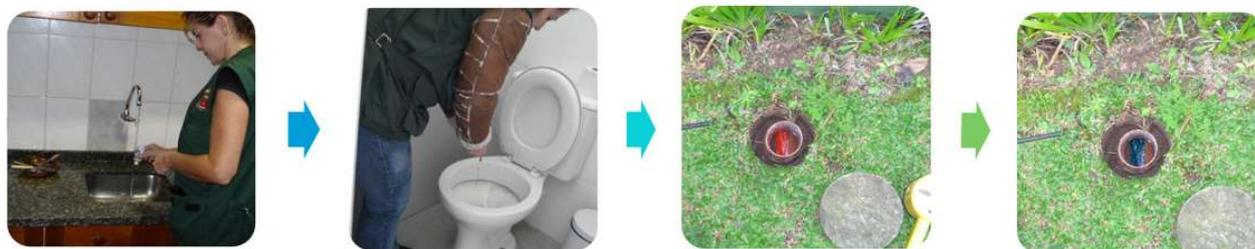
**Figura 4:** Uso de corantes biológicos em vistorias nas ligações prediais internas.
