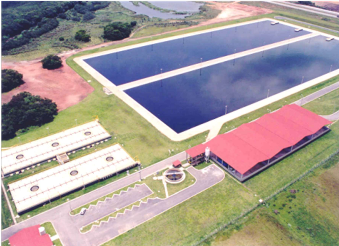
Figura 13: Vista Aérea da ETE Padilha. Fonte: SANEPAR, 2015.
