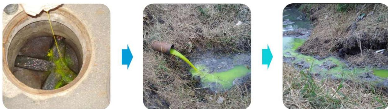
**Figura 19:** Descarte de esgoto *in natura* identificado através do despejo de corante biológico em PV da rede de esgoto.
