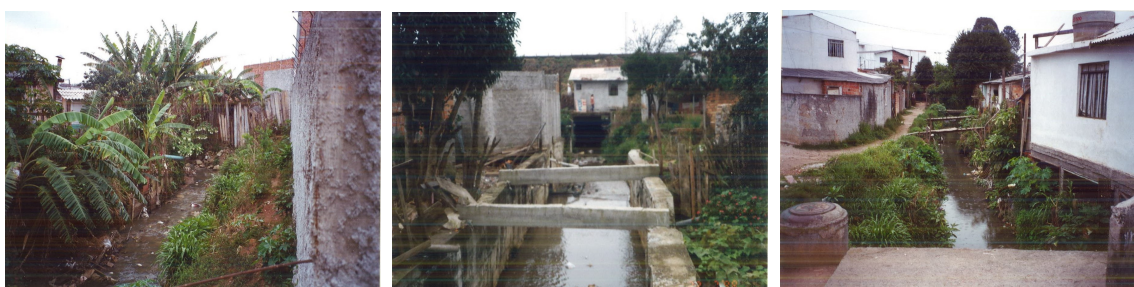
Figura 7: Obras de Contenção no Bairro Cajuru - Margens de córregos da Rua E. Bertolini e Rua Sebastião M. Luiz.
