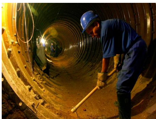
Figura 11: Fase de execução do Túnel metálico corrugado, não destrutivo, sob a Rua Padre Anchieta.
