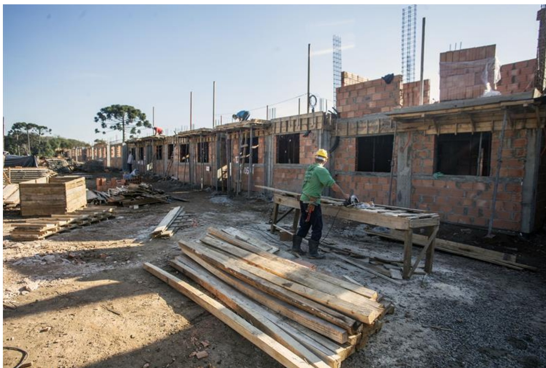
Figura 30: Obras das unidades habitacionais do Bairro Novo do Caximba. Fonte: SMCS/PMC, 2023.
