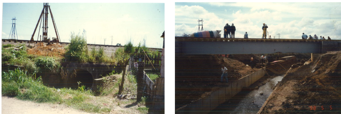
Figura 8: Galeria e desobstrução de fundos de vale - Galeria implantada na linha férrea, para evitar alagamentos devido ao represamento do escoamento das águas de vazão do fundo de vale.
