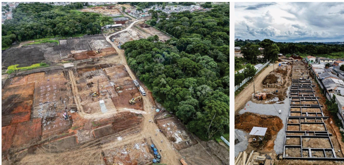
Figura 29: Início das obras no Bairro Novo do Caximba. Fonte: SMCS/PMC, 2023.
