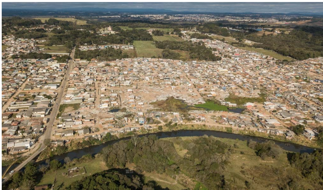
Figura 28: Ocupação irregular em área de Proteção Ambiental às margens do Rio Barigui, na Vila 29 de Outubro – Bairro Caximba.
