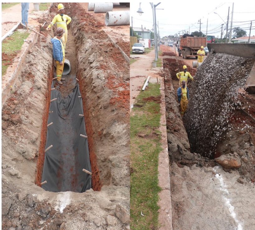
Figura 18: Sistema de Detenção e Infiltração da microdrenagem da Av. Manoel Ribas, em Santa Felicidade. Fonte: SMOP-OPO, 2023.
