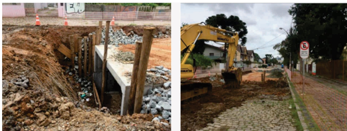
Figura 15: Canal de retenção de águas pluviais para o Rio Pilarzinho – executado na Rua Henrique Itiberê da Cunha, no trecho entre a Rua Nilo Peçanha e a Rua Tapajós. Fonte: SMOP-OPO, 2023.
