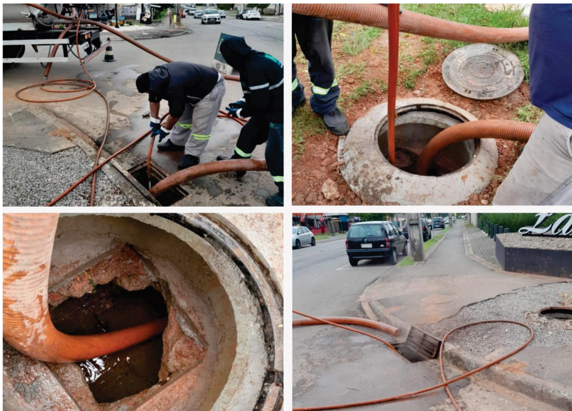
Figura 24 : Limpeza e Desobstrução de galerias de águas pluviais e poços de visita – Bairro Uberaba.
