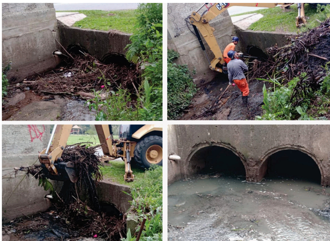
Figura 23: Limpeza e desassoreamento de canais – Bairro Atuba. Fonte SMOP-OPO, 2023.
