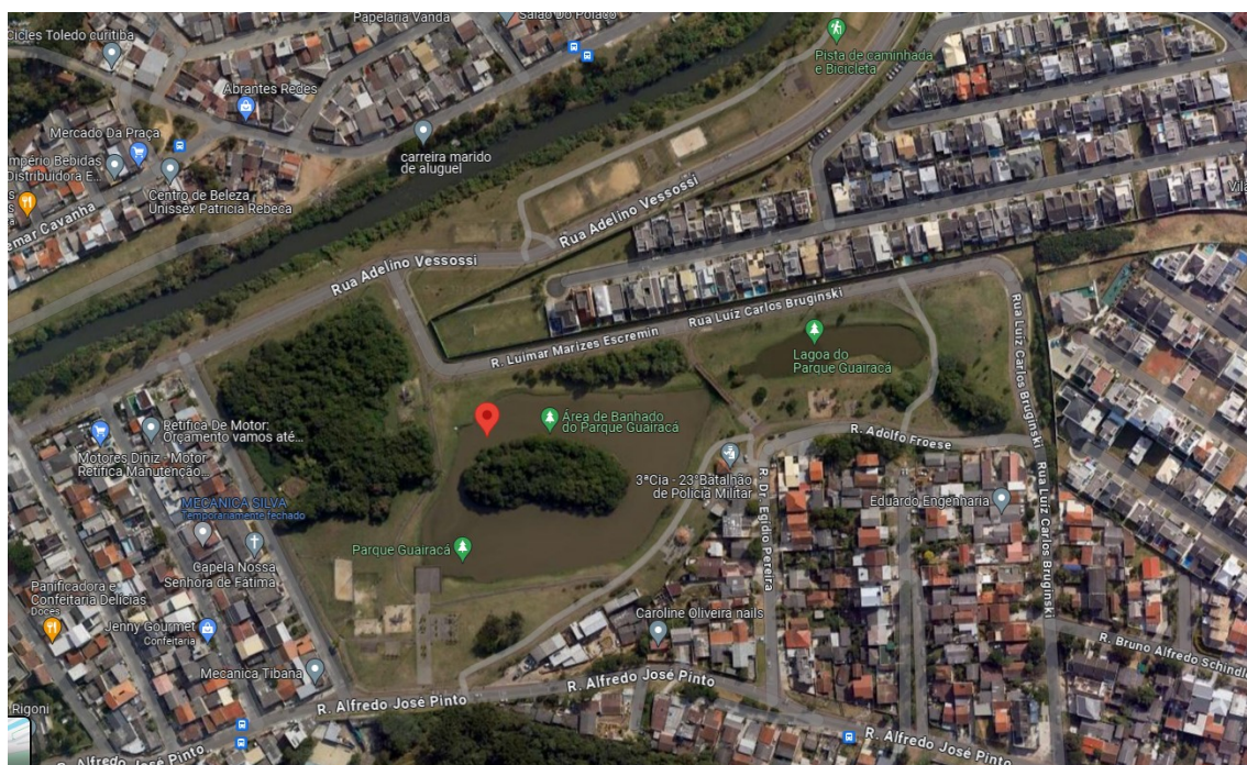
Figura 13: Reservatório de contenção de cheias do parque Guairacá, bairro Fazendinha, Curitiba.
