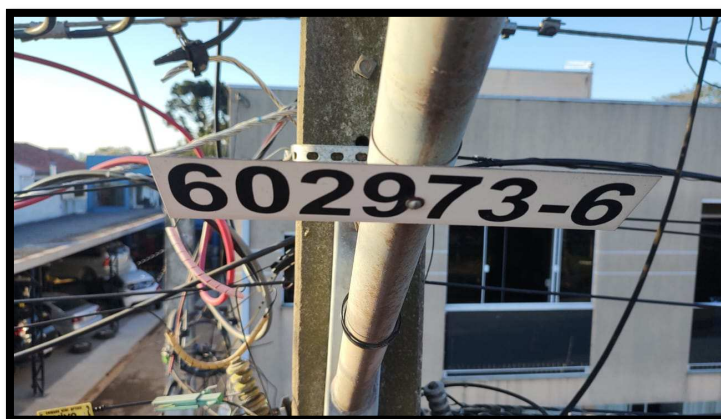
Figura 37: Plaqueta transversal ao braço, fixada com abraçadeira tipo D.
