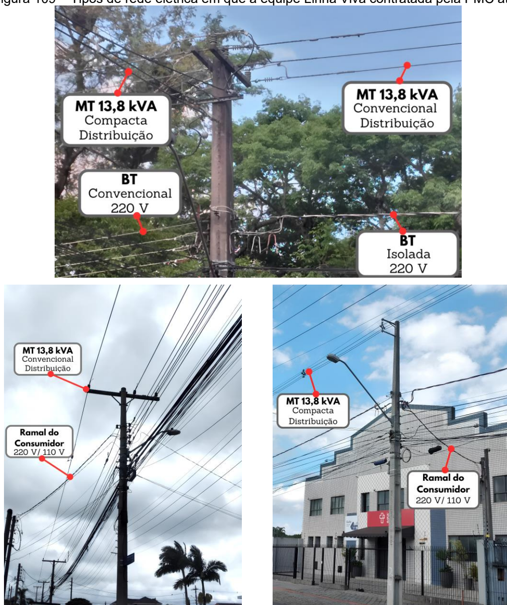
Figura 109 – Tipos de rede elétrica em que a equipe Linha Viva contratada pela PMC atua
