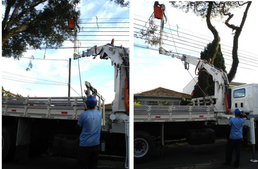
Figura 102 – Poda com guindaste utilizando corda para direcionamento da descida dos galhos
