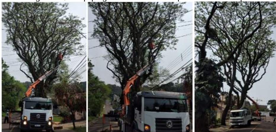
Figura 126 – Equipe guindaste realizando poda de manutenção
