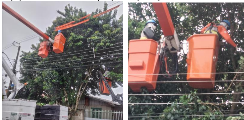
Figura 128 – Equipe Linha Viva: destaque para a proteção da rede elétrica e EPI's utilizados
