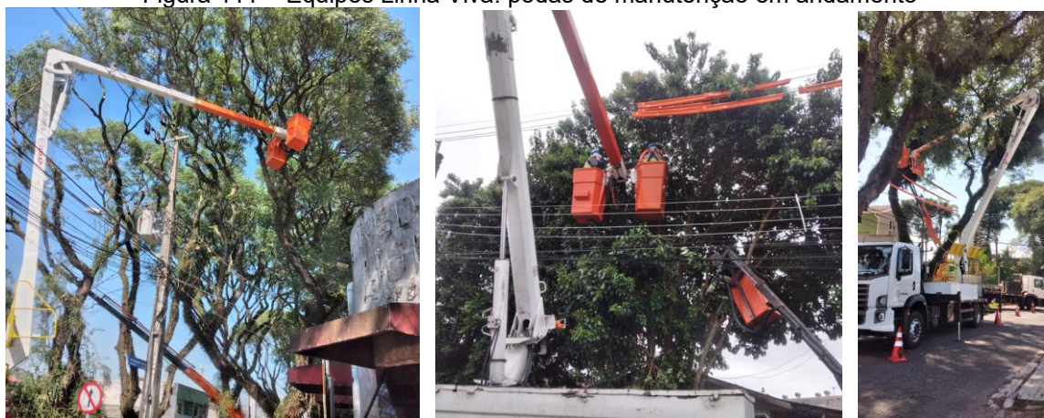
Figura 111 – Equipes Linha Viva: podas de manutenção em andamento
