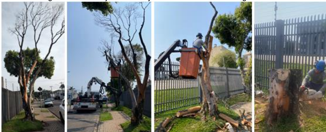
Figura 75 – Execução de remoção de árvore em UA na Regional Portão
