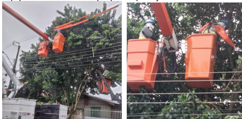
Figura 131 – Equipe Linha Viva: destaque para a proteção da rede elétrica e EPI's utilizados
