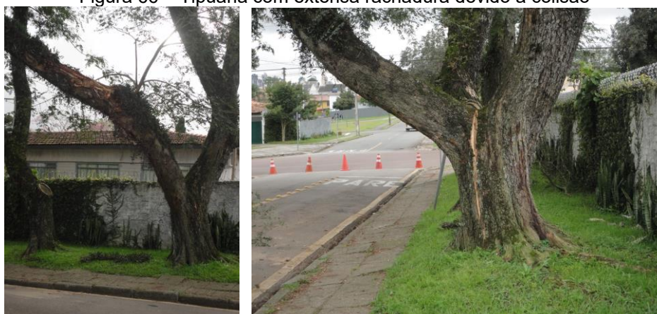
Figura 66 – Tipuana com extensa rachadura devido à colisão
