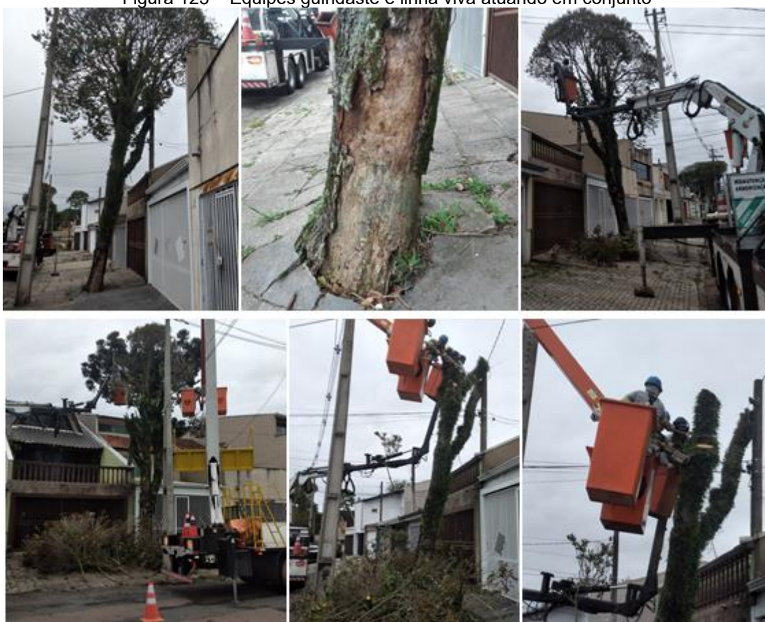
Figura 123 – Equipes guindaste e linha viva atuando em conjunto
