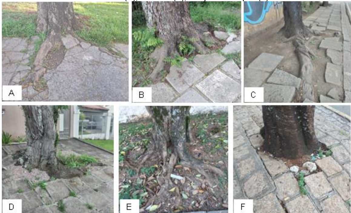
Figura 57 – Raízes danificando o calçamento: tipuana (A); koelreutéria (B); cássia-fastuosa (C); cinamomo (D); alfeneiro (E); cerejeira-do-Japão (F)
