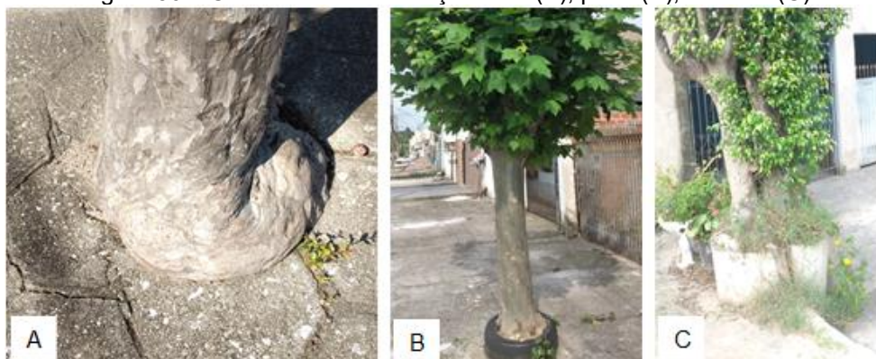
Figura 56 – Canteiro ausente: calçamento (A); pneu (B); manilha (C)
