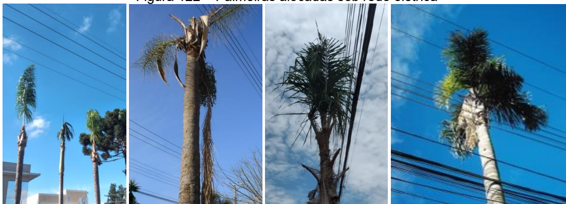
Figura 122 – Palmeiras alocadas sob rede elétrica
