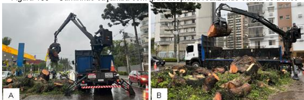
Figura 135 – Caminhão caçamba com grua acoplada realizando coleta de tronco
