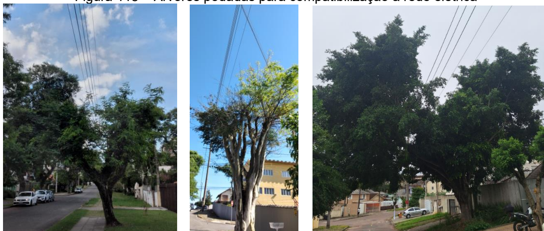
Figura 118 – Árvores podadas para compatibilização à rede elétrica
