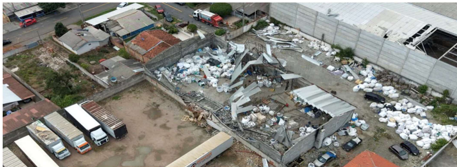
Vista da destruição em um barracão de reciclados em São José (João Frigério)
